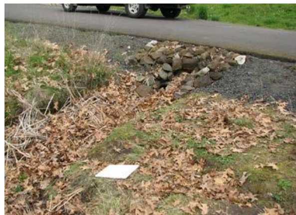
Foto 4. Alcantarilla y terreno inclinado a la orilla del camino.
